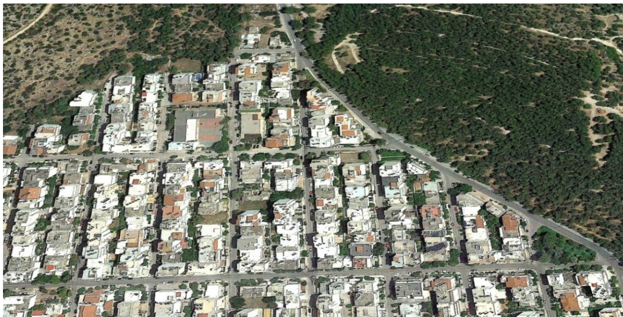
Εικόνα 1. Η δομημένη περιοχή που συνορεύει περιμετρικά με δάσος ή δασική έκταση και δεν υπάρχει συνέχεια σε καύσιμα δασικής προέλευσης μεταξύ των κτιρίων που την συγκροτούν.
